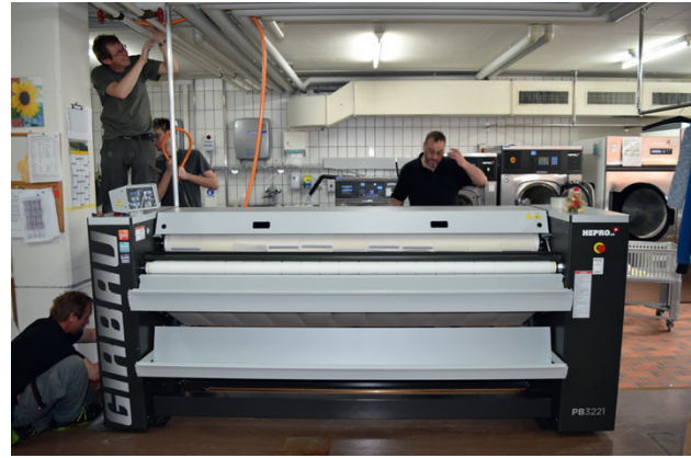
Die letzten Schritte des Einbaus
